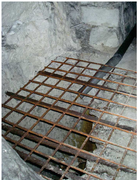
photo 2: Drainage des eaux d'infiltrations par les puits d'aération (carrière Lemée-Lévy)
