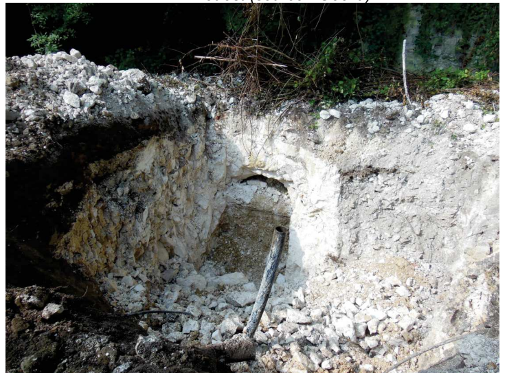
photo 11: Vides inférieurs au terrain naturel connu depuis 1849 et recoupés par des travaux de construction (source : Géolia)
