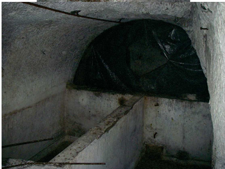
photo 6: Vestige du traitement de la craie après extraction – bassins de décantation. (carrière Lemée-Lévy-source IGC)
